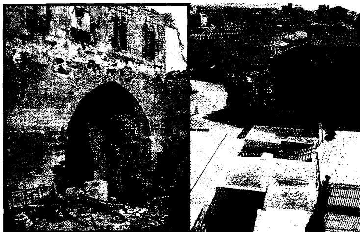
Puerta del Obispo , en León, antes y después del derribo.
