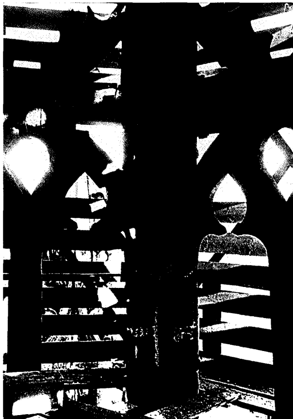
Catedral de Burgos (1927).Detalle de las grapas de hierro que sujetaban las agujas antes de la intervención de Julián Apraiz.
