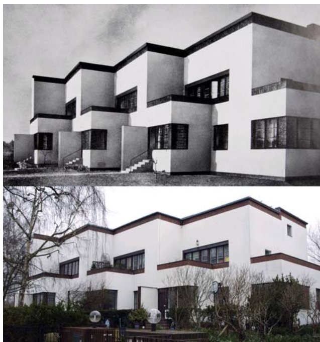
Fig.2. Fase 1. Casas de muro portante de ladrillo (1930 y 2010)
