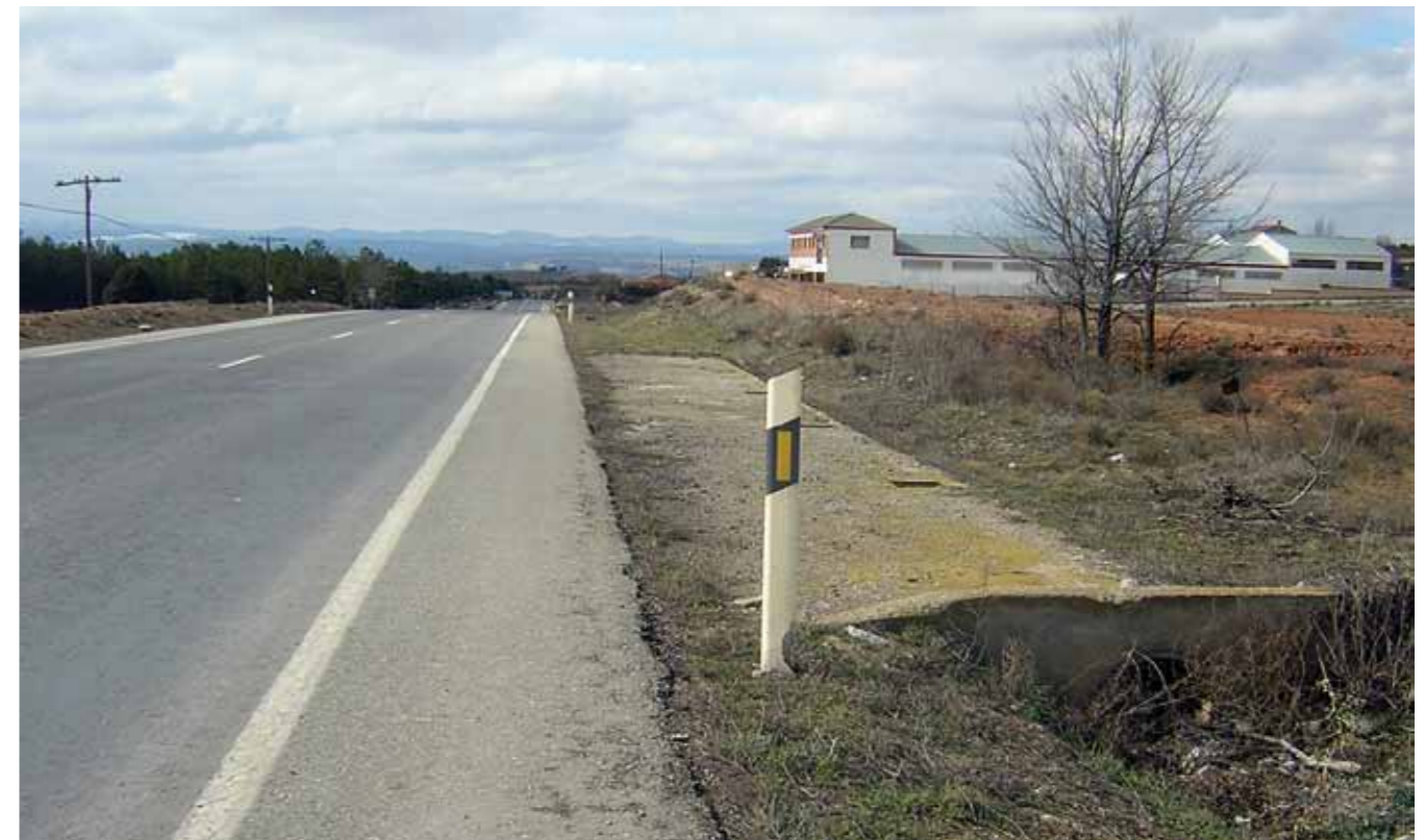
Figura 5. Indicador de obstáculos = 4: Obstáculos localizados a menos de 3 m del borde de la calzada.
