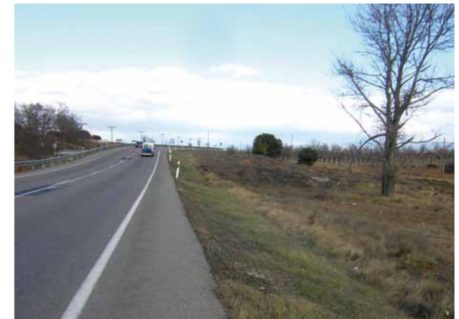
Figura 3. Indicador de inclinación de márgenes = 4: Inclinación vertical de 1:3 con desnivel de altura superior a 1 m.
