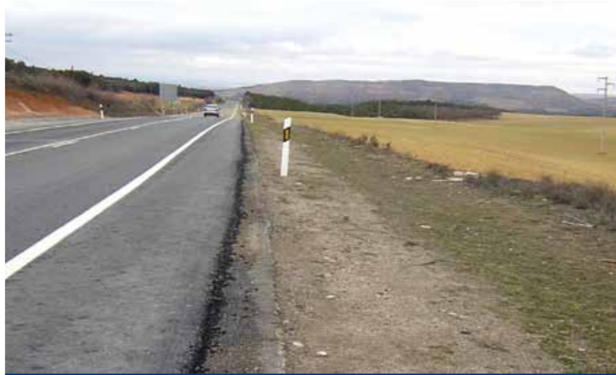
Figura 4. Indicador de obstáculos = 1: Obstáculos localizados a más de 10 m del borde de la calzada.
