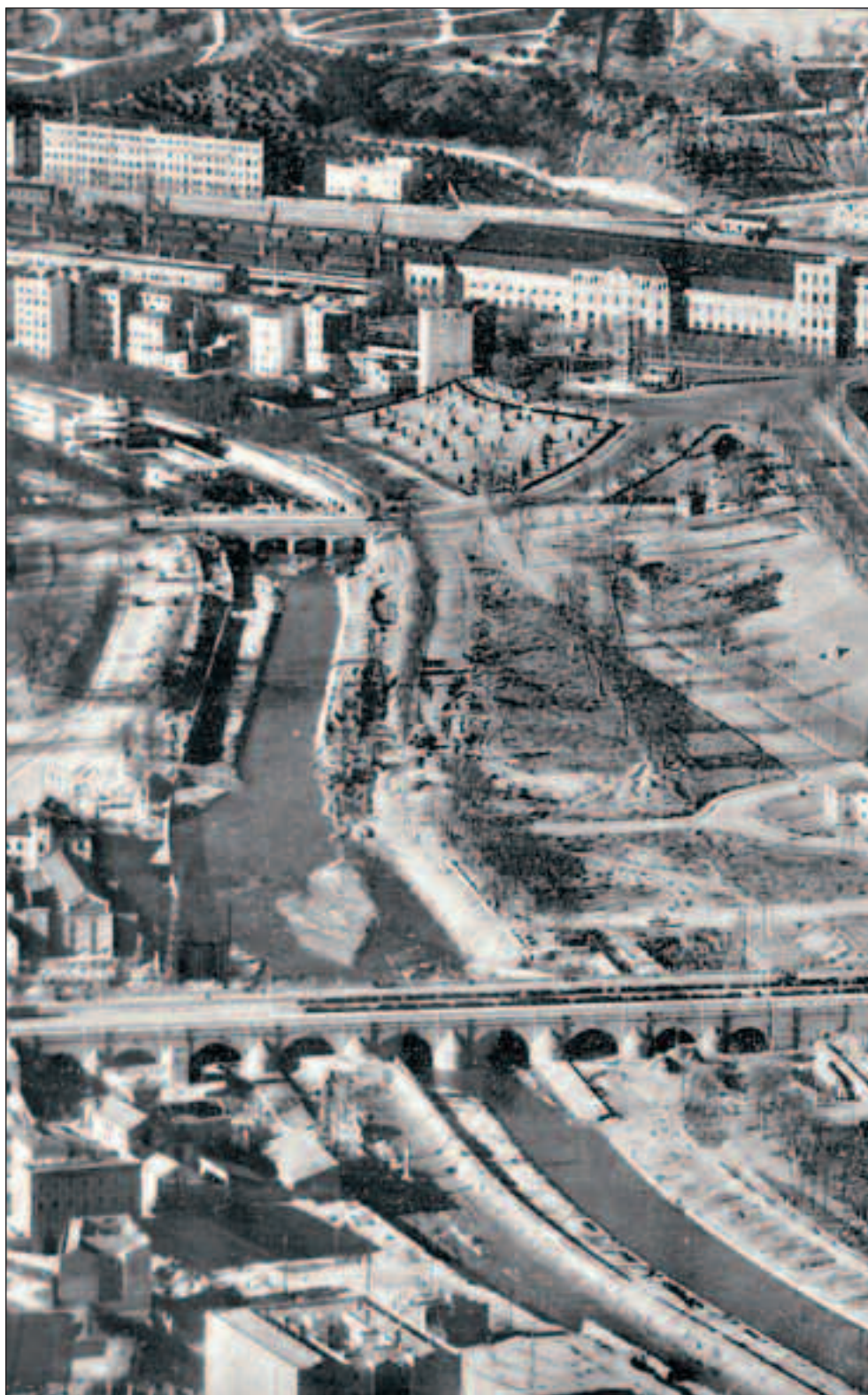
Trabajos de canalización del Manzanares hacia 1950.
