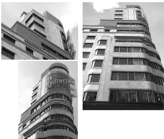
Figura 6. Detalles externos de la construcción del edificio
