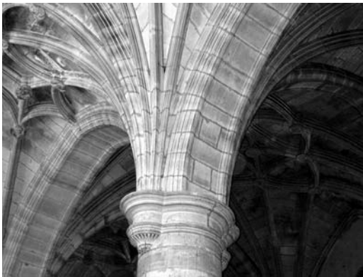
Figura 12 Detalle del arranque de las bóvedas en el pilar, con los arranques de las bóvedas a nivel
