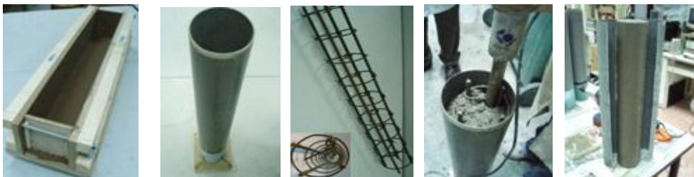
Figura nº1. Proceso constructivo de probetas-pilar.
