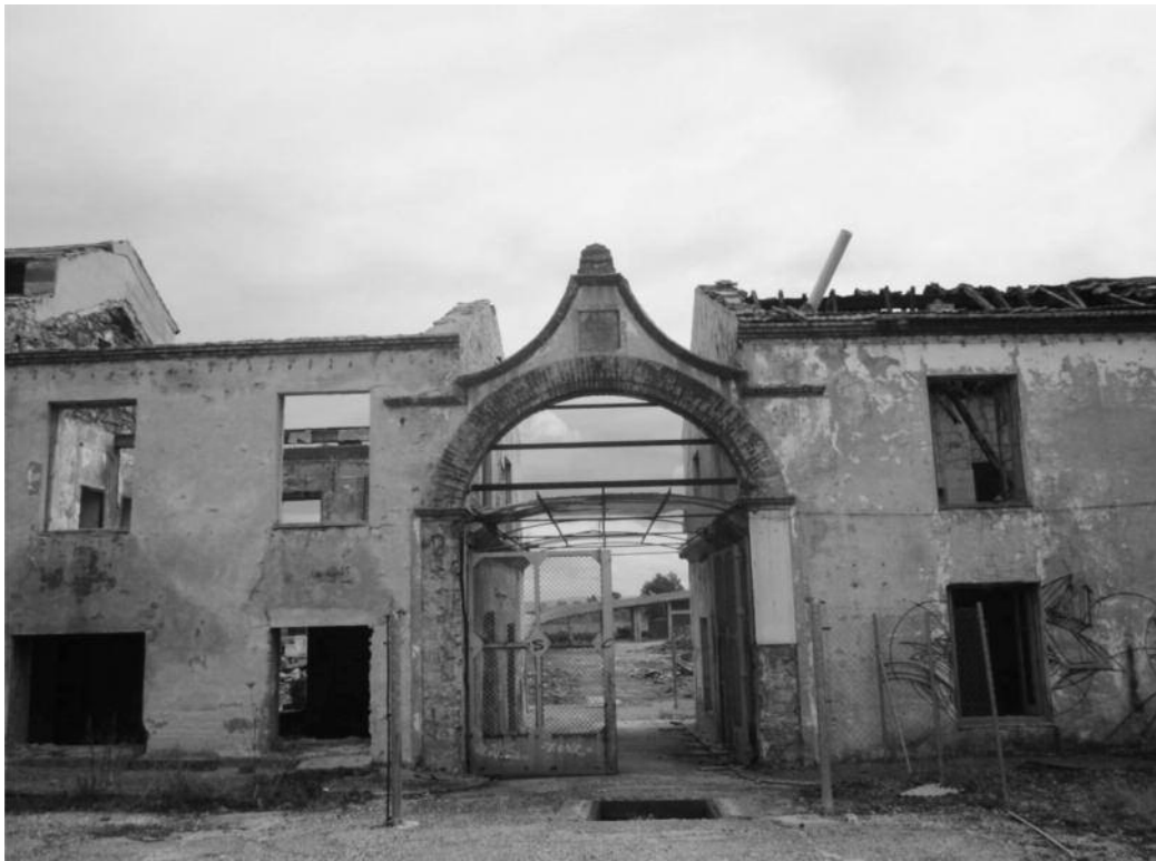
Figura 2. Antigua fundición de La Cruz, Linares, edificada en 1830.
