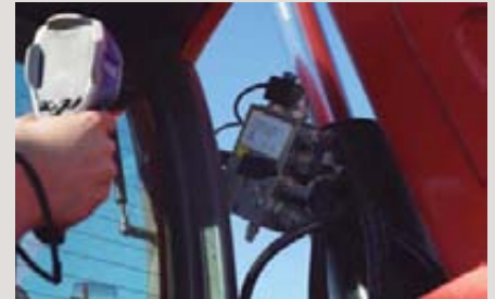
Monitorización de temperatura del distribuidor del cilindro elevador mediante tarjeta de registro y cámara termográfica.
