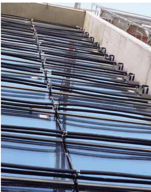
Figura. 7 Vista de los tubos distribuidores. Fuente: Página Web Intelliglass.
