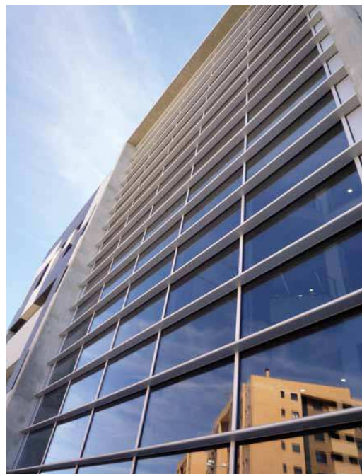
Figura. 8 Vista final exterior de la fachada. Fuente: Página Web Intelliglass.
