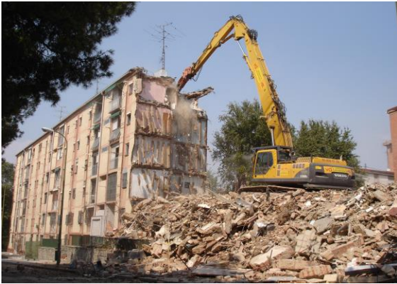
Figura 1. Edificio en demolición
