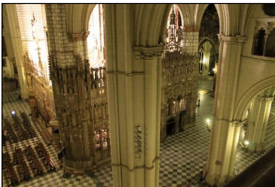
Figura 3 – Vista aérea del presbiterio
