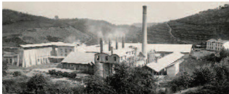
Figura 1: Vista de la fábrica de cementos Rezola en 1914.
