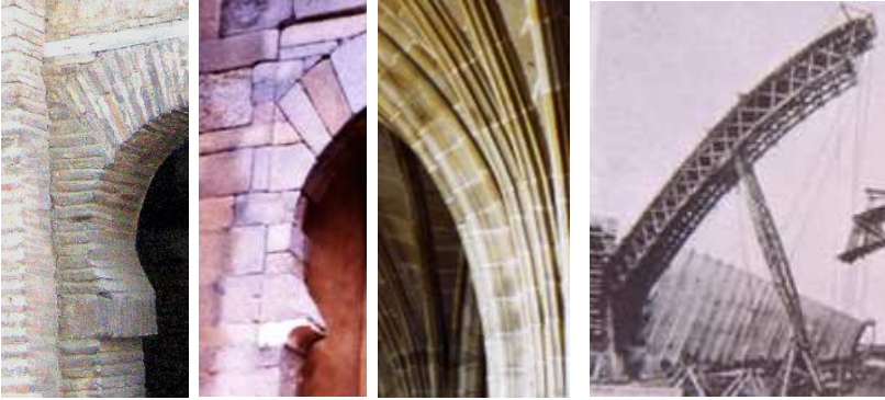
Figura 5: Arranques por orden de aparición: Cristo de la luz, Alcazaba de Badajoz, Catedral de Plasencia y Hangares de Orly.
