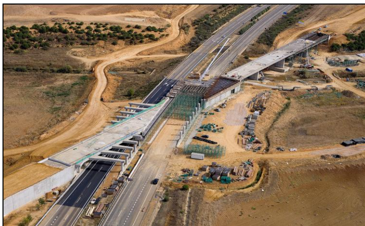
FIGURA N° 2 PÉRGOLA EN CONSTRUCCIÓN EN SEPTIEMBRE DE 2010
