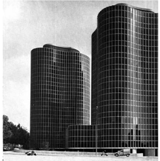
Figura 13 Edificio Trade. Barcelona (Coderch 1970)
