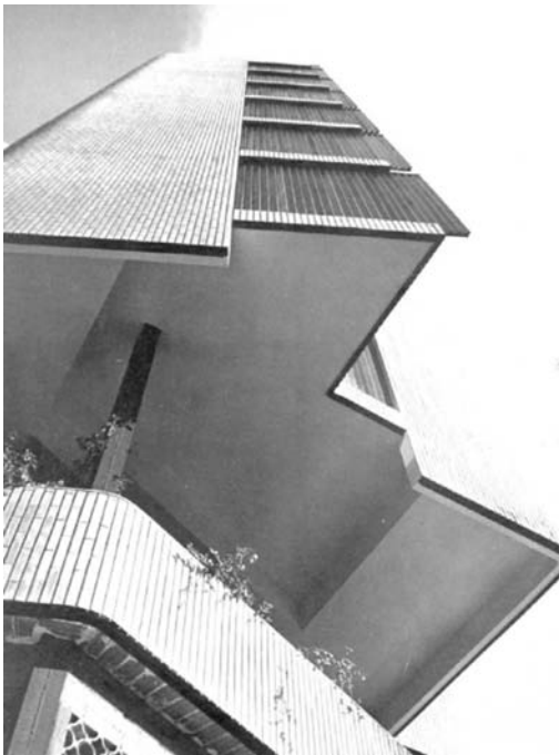
Figura 12 Edificio Girasol. Madrid (Coderch 1968)
