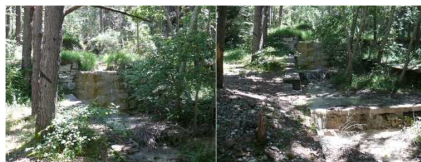
Figura 9. Detalles de estado en febrero de 2012 de dos diques secundarios, construidos entre 1903-04 en el recorrido del torrente de Arratiecho por su área de recepción. Detalles de estado en febrero de 2012 de dos diques secundarios, construidos entre 1903-04 en el recorrido del torrente de Arratiecho por su área de recepción
