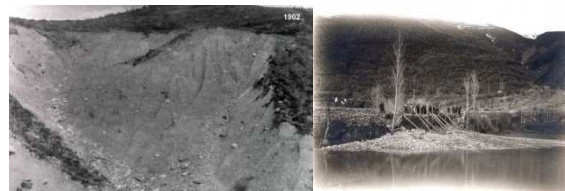
Figura 2. Cuenca vertiente al barranco de Arratiecho al inicio del siglo XX. Izquierda: erosión remontante en la cabecera de la cuenca hacia 1902 (Fotografía procedente del archivo del INIA, 2004). Derecha: Corte de la carretera N-260 por una crecida del barranco de Arratiecho hacia 1905 (Fotografía cedida por la familia Ayerbe). Cuenca vertiente al barranco de Arratiecho al inicio del siglo XX . Izquierda: erosión remontante en la cabecera de la cuenca hacia 1902 (Fotografía procedente del archivo del INIA, 2004). Derecha: Corte de la carretera N-260 por una crecida del barranco de Arratiecho hacia 1905 (Fotografía cedida por la familia Ayerbe).
