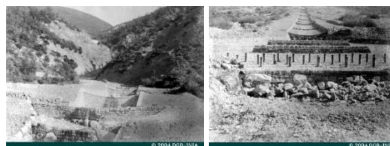
Figura 6. Cono de sedimentación del torrente de Arratiecho hacia 1904. Izquierda: trabajos de encauzamiento en el primer tramo del cono de sedimentación del torrente, ejecutados para asegurar el servicio de la carretera N-260. Derecha: vista del segundo tramo de dicho encauzamiento (Fotografías procedentes del archivo del INIA, 2004). Cono de sedimentación del torrente de Arratiecho hacia 1904. Izquierda: trabajos de encauzamiento en el primer tramo del cono de sedimentación del torrente, ejecutados para asegurar el servicio de la carretera N-260. Derecha: vista del segundo tramo de dicho encauzamiento (Fotografías procedentes del archivo del INIA, 2004).
