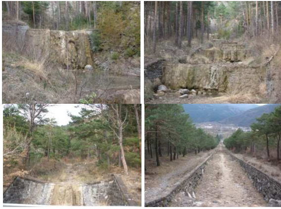
Figura 12. Canal escalonado de tramos erosionable (1904) que atraviesa el cono de sedimentación del torrente de Arratiecho, en marzo de 2012. Imágenes superiores. Izquierda: dique de mampostería hidráulica de primer orden número 3, en el vértice del cono de sedimentación. Derecha: inicio del tramo encauzado del torrente aguas abajo del dique anterior. Imágenes inferiores. Izquierda: dique de mampostería hidráulica de segundo orden situado inmediatamente aguas arriba de la carretera N-260, al fondo el canal. Derecha: el canal inmediatamente aguas abajo de dicha carretera (las dos imágenes inferiores se corresponden con las fotografías de la Figura 6). Canal escalonado de tramos erosionable (1904) que atraviesa el cono de sedimentación del torrente de Arratiecho, en marzo de 2012. Imágenes superiores. Izquierda: dique de mampostería hidráulica de primer orden número 3, en el vértice del cono de sedimentación. Derecha: inicio del tramo encauzado del torrente aguas abajo del dique anterior. Imágenes inferiores. Izquierda: dique de mampostería hidráulica de segundo orden situado inmediatamente aguas arriba de la carretera N-260, al fondo el canal. Derecha: el canal inmediatamente aguas abajo de dicha carretera (las dos imágenes inferiores se corresponden con las fotografías de la Figura 6).
