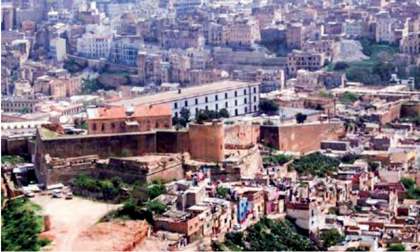
Figura 9. Rosalcazar en la actualidad, con construcciones ilegales adosadas a sus murallas.
