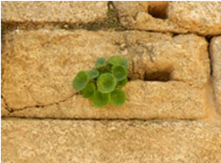
8. Plantas menores crecen entre las grietas y huecos en los que se acumula la suciedad y la humedad
