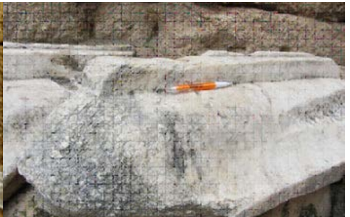
18. Cornisa de mármol blanco en el podio del frente escénico, degradación por disgregación granular.
