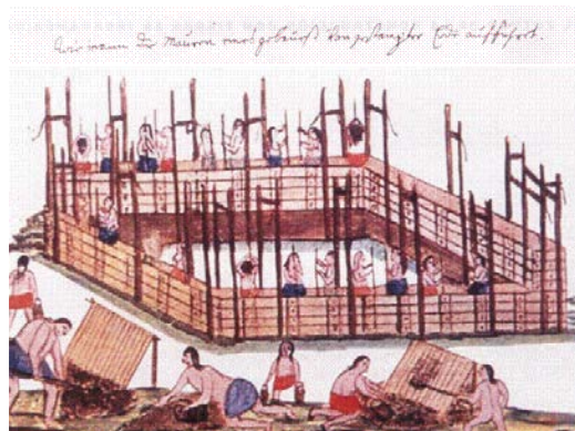
Figura 1: Modo de levantar las paredes con tierra apisonada. Fuente: Pereira, 1995.
