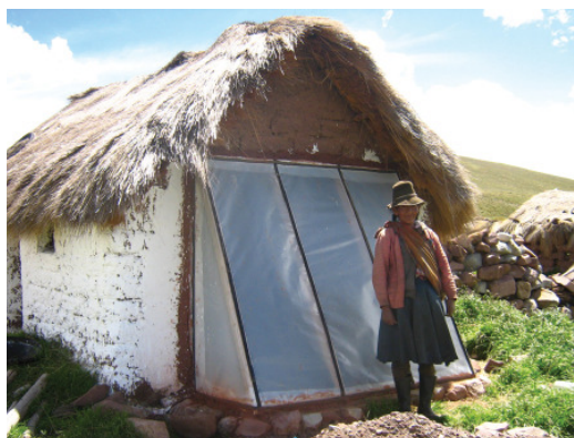
Figura 5: Sistema de aprovechamiento solar mediante "pared caliente" llevado a cabo por el Grupo de Apoyo al Sector Rural. Fuente: Alayza, 2.011.
