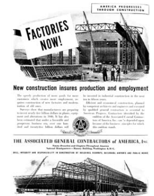
Fig. 1. Anuncio: The Associated General Contractors of America. Architectural Record , noviembre de 1945.
