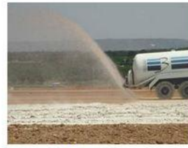
3.Apagado de la cal: En el caso de utilizar cal viva será necesario apagar la cal in situ mediante un riego de la cal extendida.
