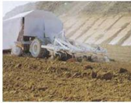
1.Preparación del suelo: Escarificar para favorecer la mezcla suelo-cal. No siempre es necesaria.
