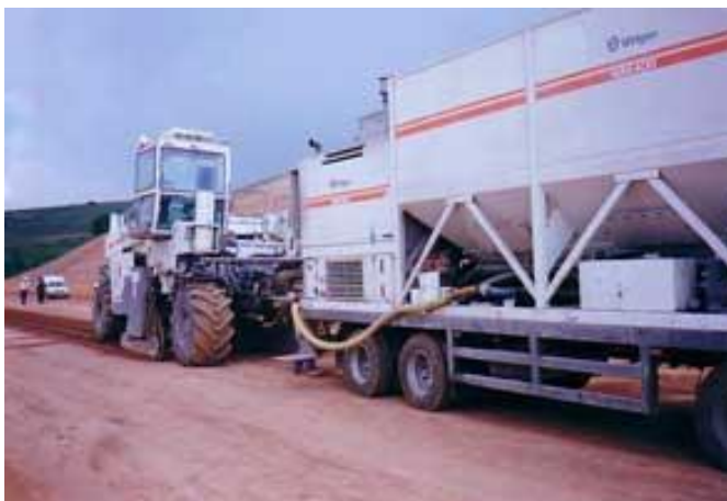
Fig. 2 Estabilización in situ, con cemento.
