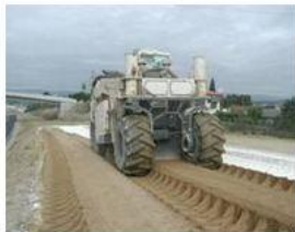
4.Mezclado: Esta operación debe conseguir una mezcla íntima entre el suelo y la cal. Es recomendable el uso de pulverizadores de alta energía mecánica de mezcla.
