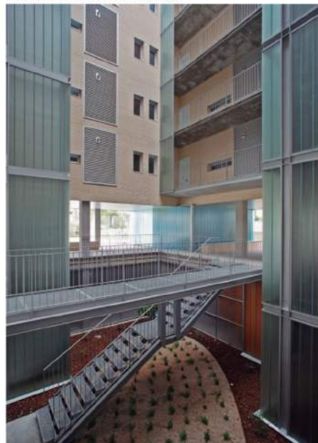
Foto: 24 viviendas en Fuenlabrada
