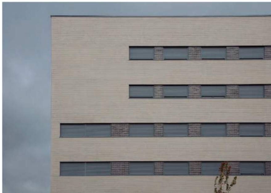
Foto: 18 viviendas en Fuenlabrada
