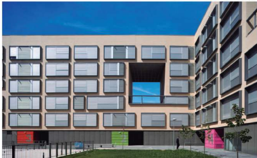
Foto: 114 viviendas VPT en Fuenlabrada
