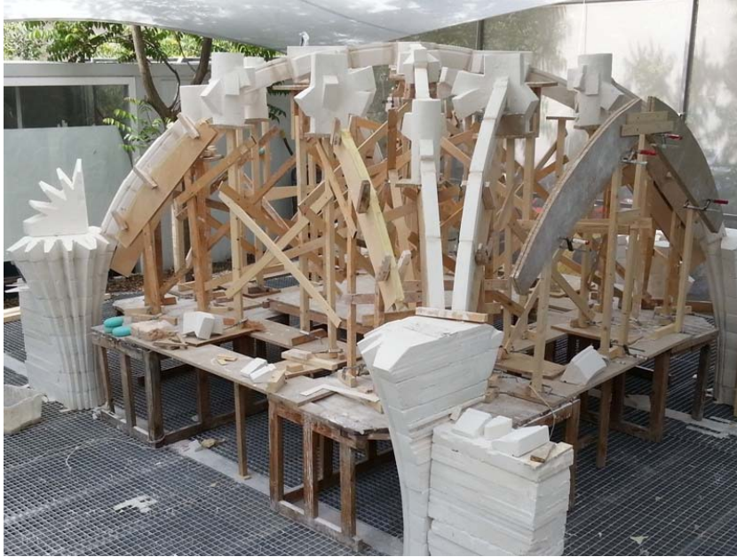
Figura 9. Montaje de la plataforma de trabajo, las cimbras curvas y los pies derechos, ya coronados con sus correspondientes claves (imagen autores).
