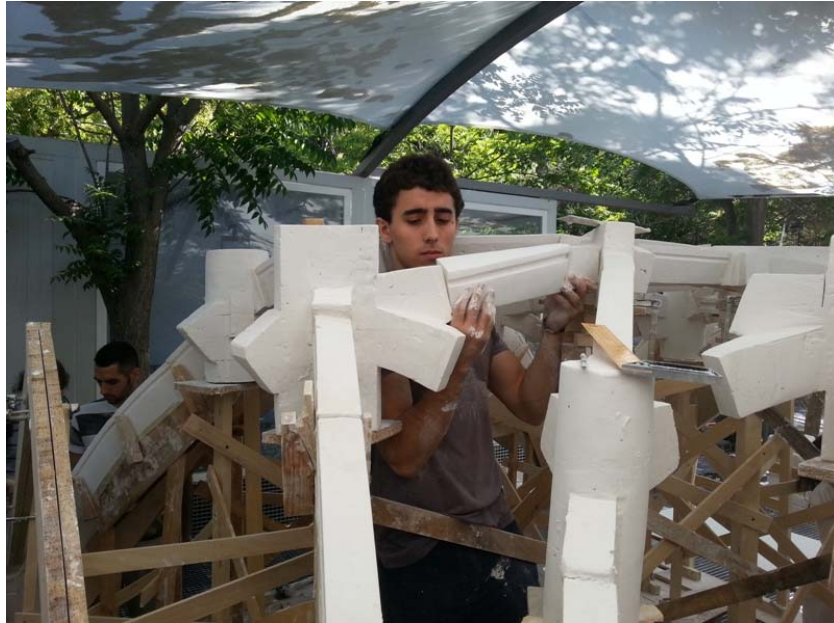
Figura 10. Invariablemente entre las claves sólo cabe una pieza (imagen autores).
