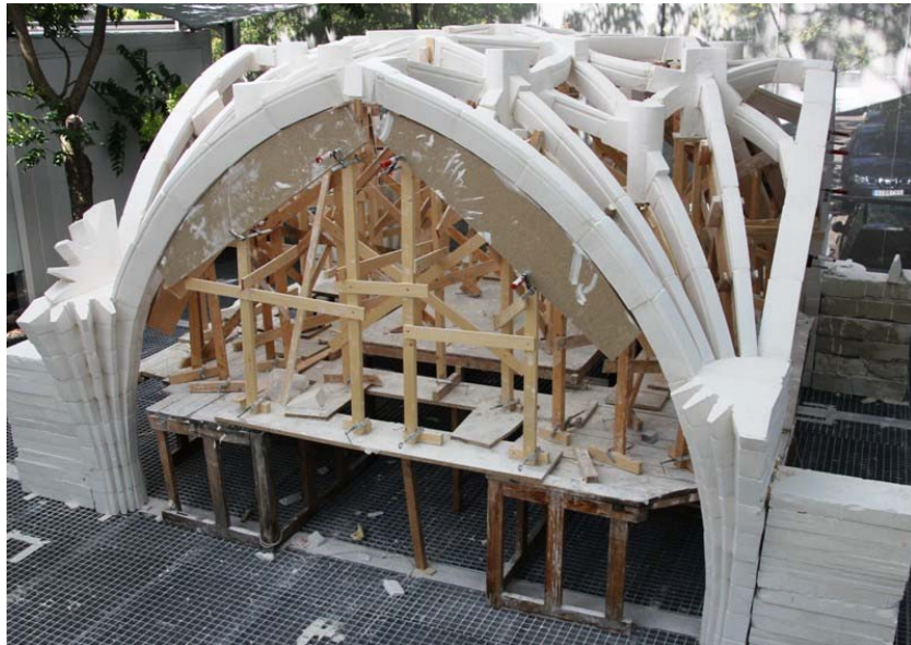
Figura 11. La bóveda ya terminada revela su rampante llano originado por la estandarización de sus arcos principales (imagen autores).
