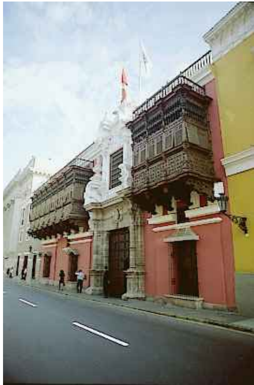
Balcones barrocos del Palacio Torre Tagle
