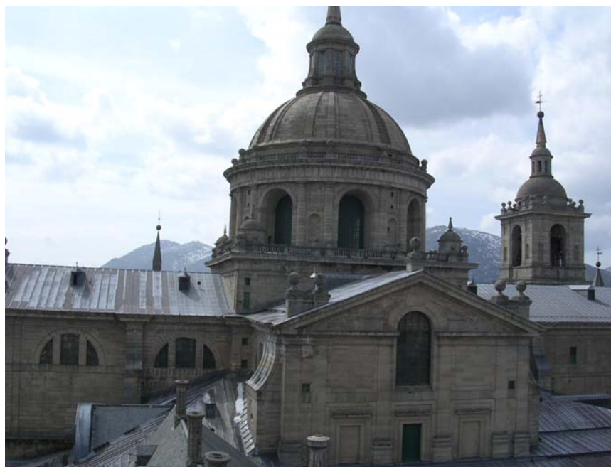
Vista exterior de la basílica.
