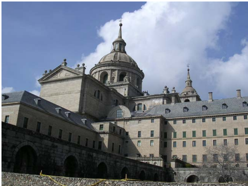
Vista exterior de la basílica.
