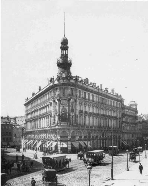
Figura 1 Edificio de la Equitativa a finales del siglo XIX. (Valcárcel 2003)
