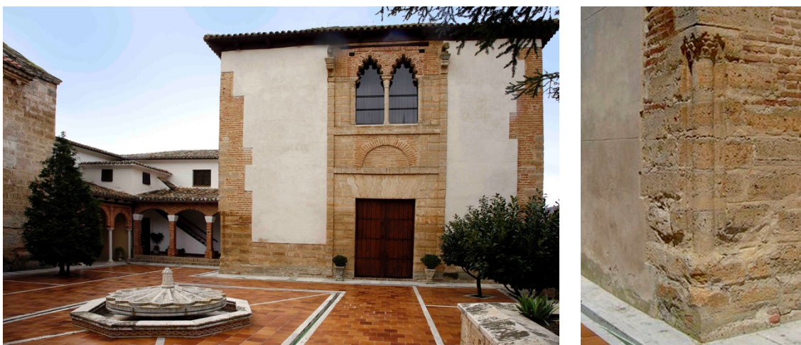
Figs. 42 y 43. Palacio de Astudillo, Palencia. Fachada principal con la portada de acceso y detalle de columna en la esquina sureste de la misma fachada (Imágenes de Laura Illana Gutiérrez y Alberto Fernández Ferrero, sin fecha).
