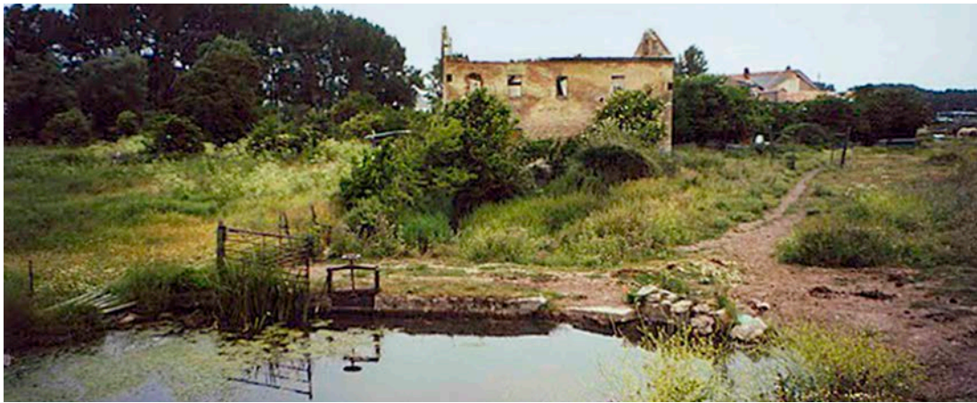
Fig. 268. Casa de la Vega en Gamonal. Presa del molino (fuente: Rubio Marcos, 2002).
