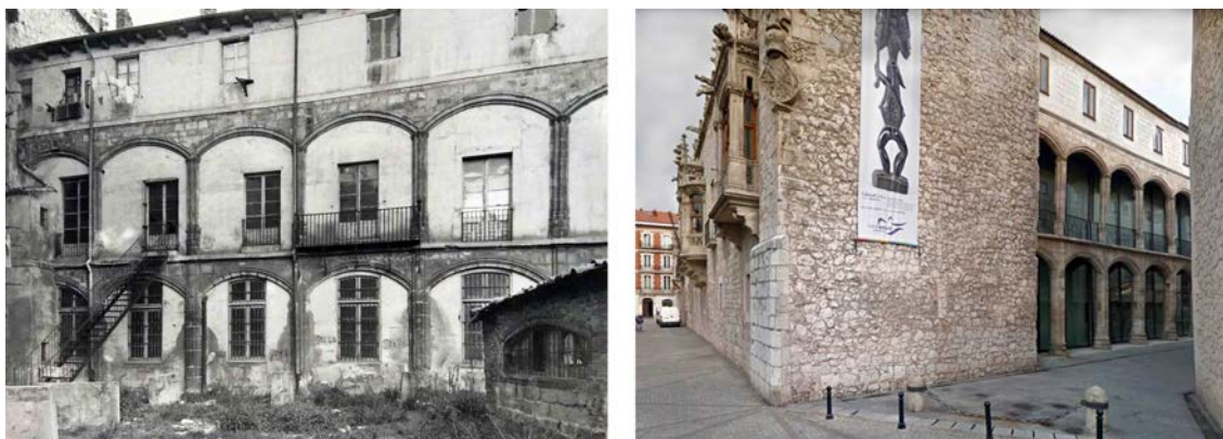
Figs. 260 y 261. Casa del Cordón, Burgos. Galerías del jardín. Estado anterior a la restauración de 1983-1987 (con restos de una pequeña edificación cuyas primeras hiladas podrían pertenecer a una de las capillas de 1492) y estado actual hacia el pasaje Vicente Lampérez (fuente: Ibáñez Pérez, 1987, y Google Maps, 2015).
