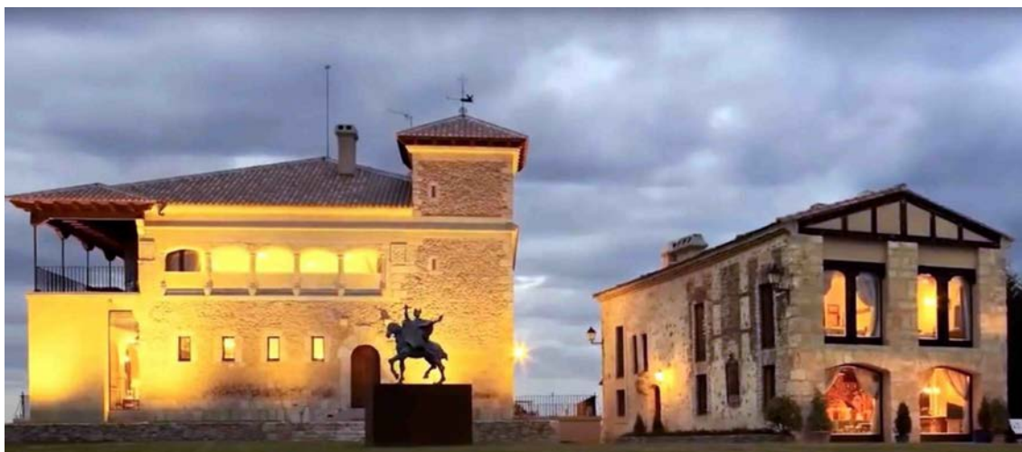
Fig. 177. Bosque de La Serreta. Estado de los edificios tras la reforma de 2005 (fuente: lastrasdecuellar.net ).
