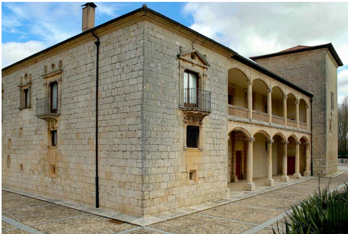
Fig. 406. Quinta de Saldañuela. Fachada principal del edificio con su torre y galería (foto de Santiago López Pastor, marzo de 2015, disponible en https://castillosdelolvido.com/torre-palacio-de-saldañuela/ ).
