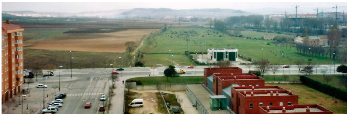
Fig. 238. Los prados y edificios de la Casa de la Vega (a la derecha) ocupados o rodeados por diferentes promociones de viviendas y equipamientos (foto de Enrique López Modrón, 2003, poco antes del derribo).
