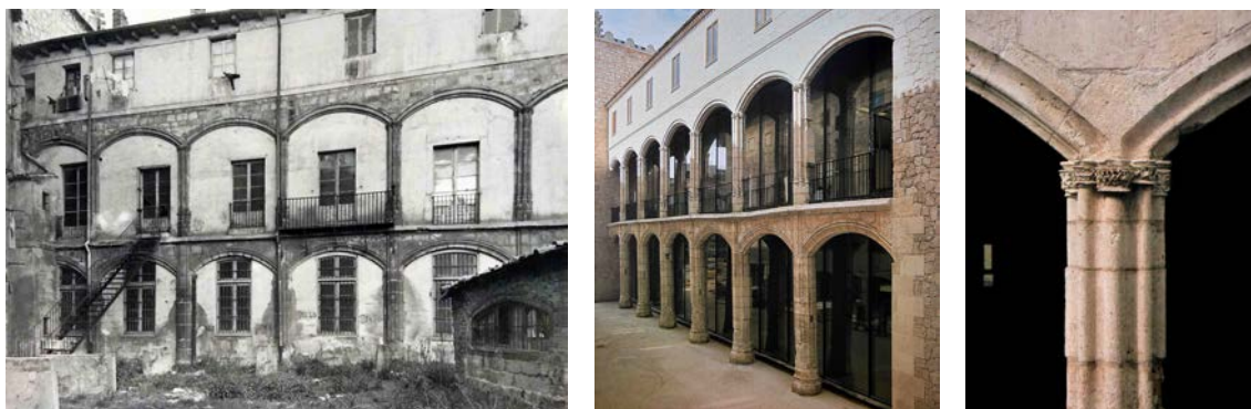
Figs. 245, 246 y 247. Casa del Cordón. Izquierda: galería del jardín antes de la restauración de 1983-1987. Centro: estado restaurado. Derecha: detalle de uno de los soportes de la galería alta (tomado de Ibáñez Pérez, 1987).
