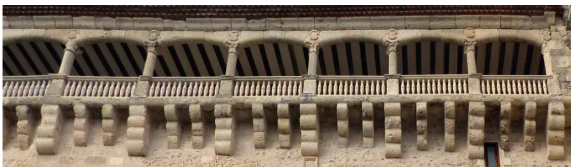
Fig. 156. Castillo-palacio del duque de Alburquerque en Cuéllar. Galería proto-renacentista, coetánea del palacio rural de Buengrado (foto de Benjamín Núñez González, 2016, Wikimedia Commons).
