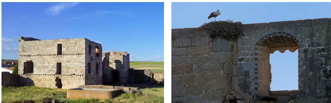
Figs. 195 y 196. Palacio rural de Mancera de Abajo. Izquierda: fachada suroeste, con los mechinales para la vigería de los corredores volados (fuente: imagen de Artesiver en https://listaroiopatrimonio.org , anterior al 15 de febrero de 2008). Derecha: vano de la planta superior y su decoración de pomas isabelinas al interior y lobulada o angrelada al exterior (fuente: https://www.geocaching.com ).
