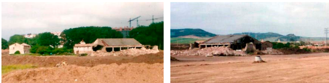
Figs. 239 y 240. Casa de la Vega en Gamonal, Burgos. Fotografías de los edificios durante su derribo, con parte de los muros antiguos casi completamente demolidos y la nave de los años sesenta todavía en pie (imágenes de Enrique López Modrón, mayo de 2003).
