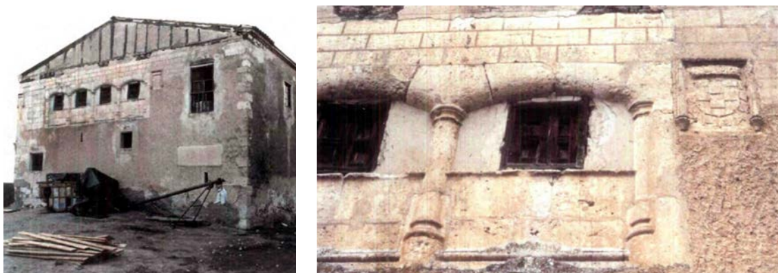
Figs. 167 y 168. Casa de La Serreta. La galería oriental y las armas de los Toledo antes de la reconstrucción y ampliación del edificio (Hernández Montero, 1994, tomadas en 1989).
