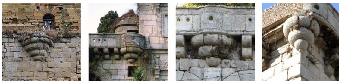
Figs. 290, 291, 292 y 293. Apoyos pseudo-castrenses de tipo escaraguaita en los palacios de Casalarreina (foto1, fuente: http://turismocasalarreina.es/patrimonio ) y Cadalso de los Vidrios (José Muñoz Domínguez, 1995, para la segunda imagen y María Ramírez de Arellano Torrico, 2014, para el resto).
