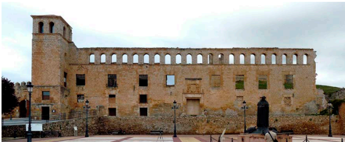
Fig. 339. Palacio-villa de Berlanga de Duero, Soria. Fachada principal del edificio hacia la Plaza del Mercado (fuente: imagen de Rowanwindwhistler, Wikimedia Commons, mayo de 2010).
