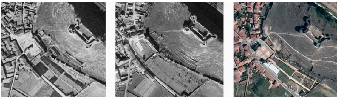
Figs. 365, 366 y 367. Palacio-villa de Berlanga de Duero. Secuencia de fotogramas aéreos históricos de 1956, 1973-1986 y 2017 con las sucesivas pérdidas arquitectónicas del edificio (fuente: Fototeca del IGN-PNOA).
