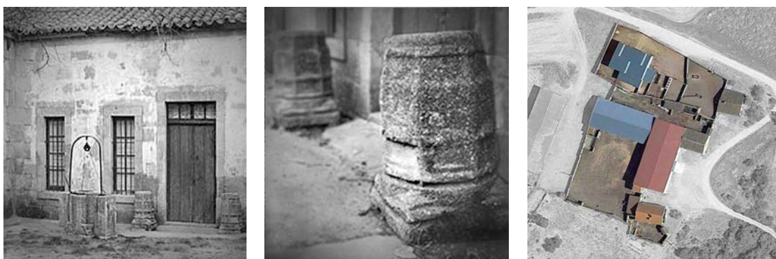
Figs. 53, 54 y 55. Granja de Valcuevo en Valverdón, Salamanca. En las dos primeras imágenes, restos conservados de la casa de reposo (tomadas de http://perso.wanadoo.es/valverdon_un/valc_casa.htm ). La tercera imagen muestra el estado actual del conjunto (fuente: PNOA, 2021).
