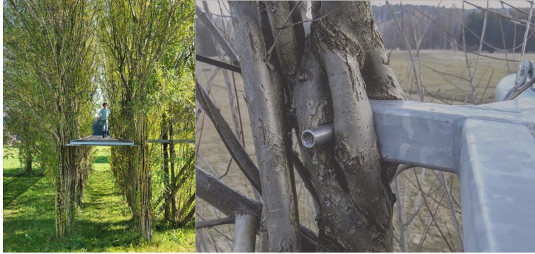
Fig. 23. Plataforma construida sobre una estructura de árboles inoculados.
