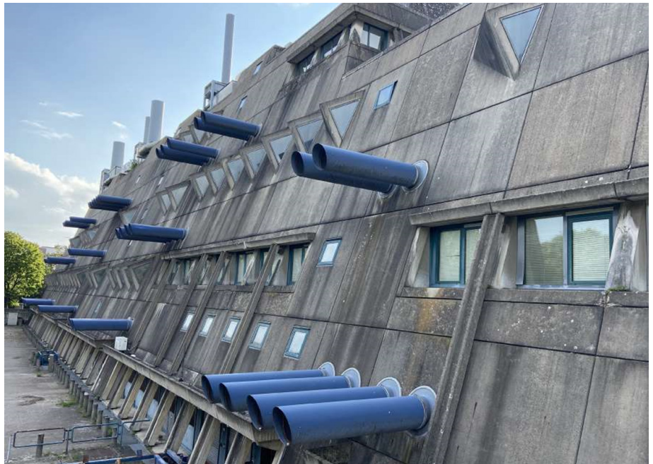
Fig. 59. Vista exterior del Mäusebunker. 2021. Imagen propia.
