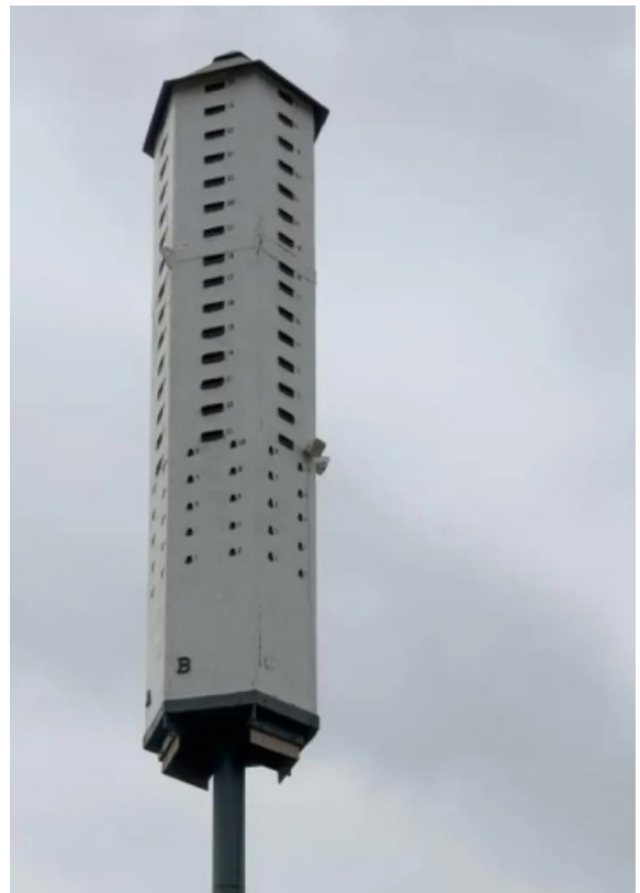
Fig. 20. 'Torre de la Biodiversidad', Coria del Río, Sevilla.
