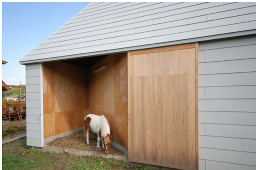
Fig. 24. Casa Jardín Poni, Kanagawa, Japón. Atelier Bow-Wow. Arquitectos. 2008. 1.
