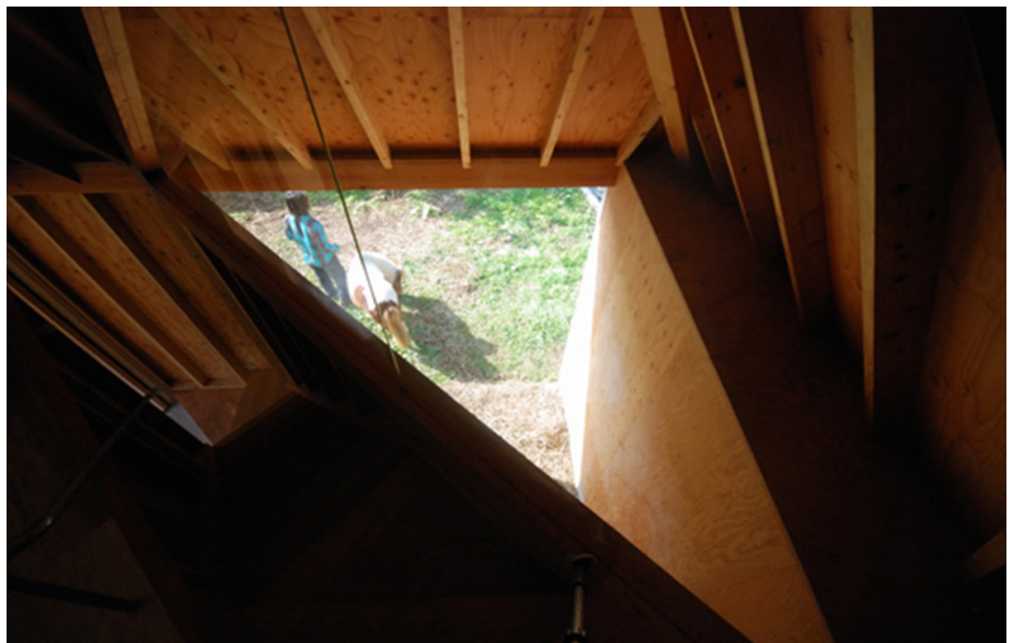
Fig. 25. Casa Jardín Poni, Kanagawa, Japón. Atelier Bow-Wow. Arquitectos. 2008. 2.
