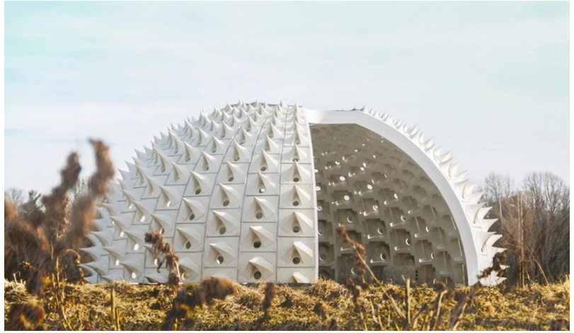
Fig. 80. Vista exterior de la cúpula.
