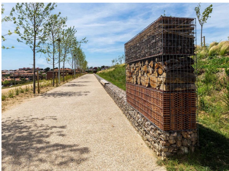
Fig. 67. Batlle i Roig Arquitectes, Hotel para insectos.
