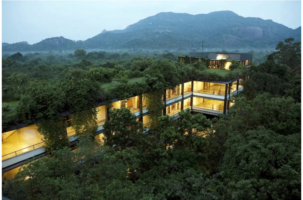
Fig. 56. Hotel Kandalama. Sri Lanka. Vista fachada vegetal. Arquitecto Geoffrey Bawa.
