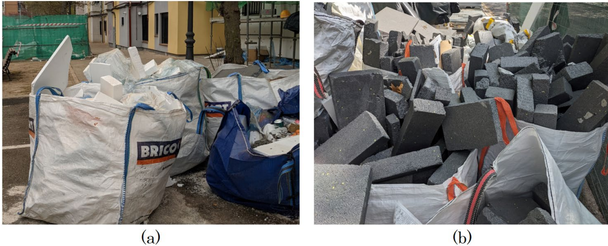
Figura 5: Residuos de EPS generados durante la ejecución de SATE: (a) EPS convencional, (b) EPS con grafito (Fuente: Propia)
