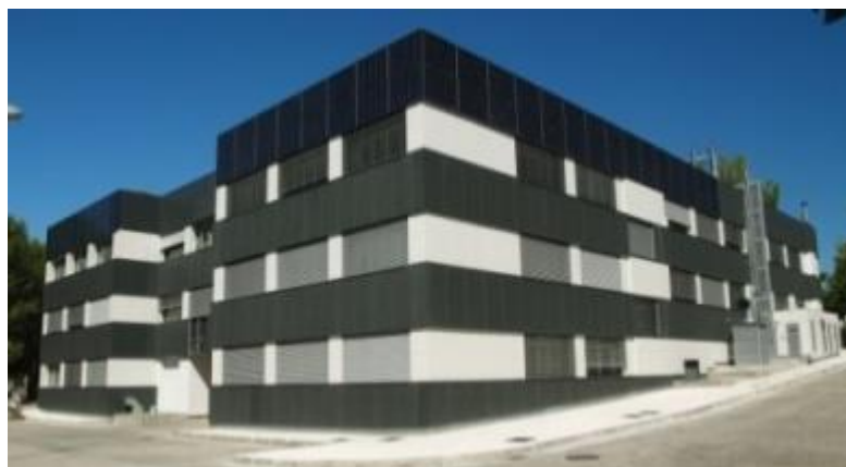
Figura 29. Edificio con integración fotovoltaica en su fachada
