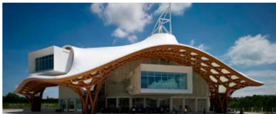
Fig. 60: Centro Pompidou, Metz. Vista exterior
