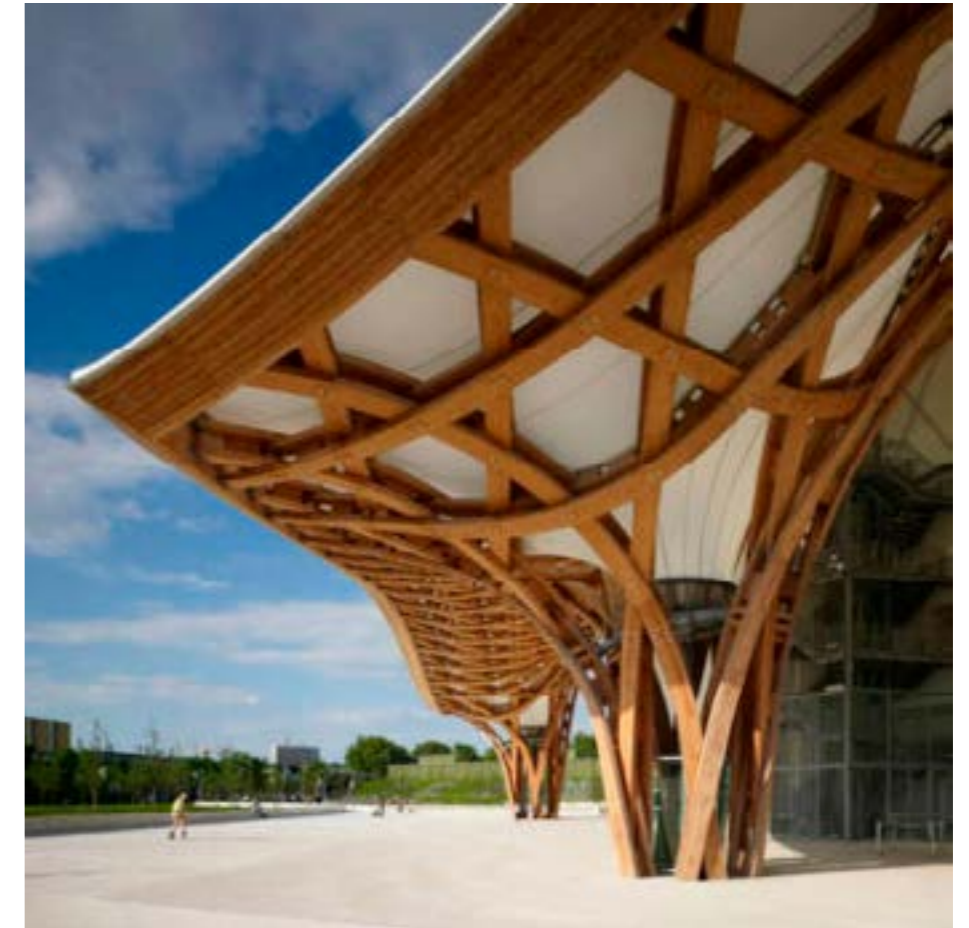
Fig. 61: Centro Pompidou, Metz. Detalle de la deformación en el pilar
