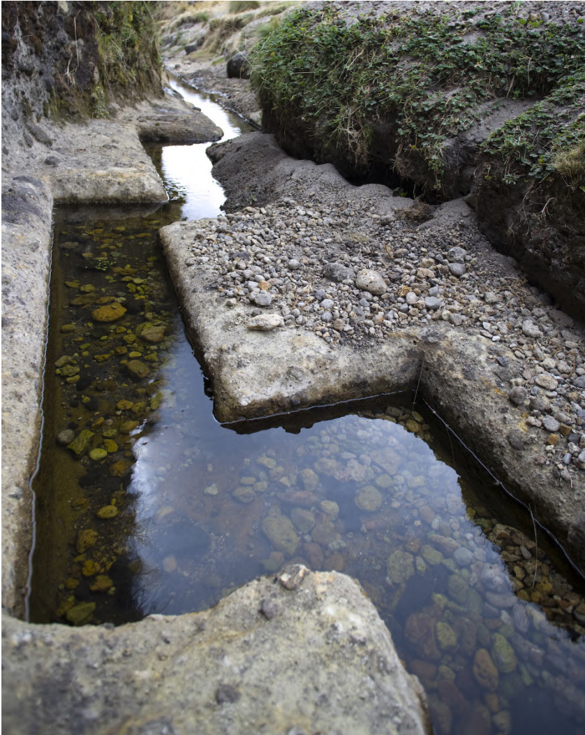
Fig. 21: El canal de Cumbemayo es una obra de ingeniería hidráulica donde, sin embargo, se puede percibir una voluntad estética en su trazado.
