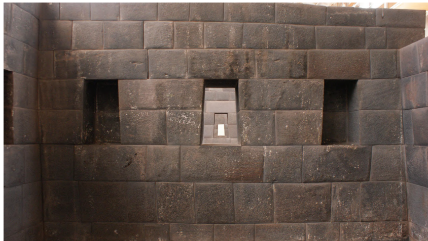
Fig 2. Muros del Qorikancha . Fuente: Elaboración propia
