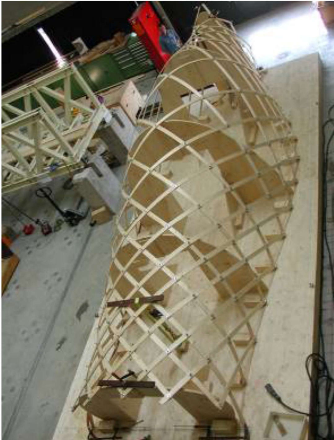
Fig. 14. Imagen durante el montaje. Geodesic ribbed shell
