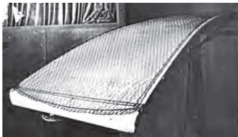
Fig. 08. Armado de uno de los módulos de la cúpula
