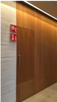
3.71 Protección activa contra incendios
