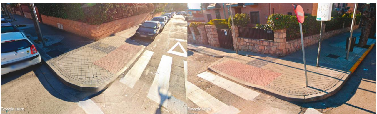
Figura 32. Estado existente de orejetas peatonales en calle de Esparta. Fuente: Google Earth, enero 2022.
