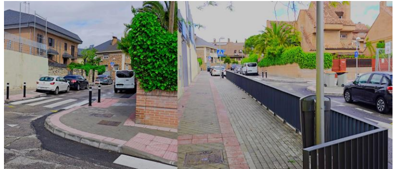
Figura 39. Estado ejecutado de orejetas peatonales y barandilla tipo Río MU-72 en calle de Esparta (mayo 2025).
