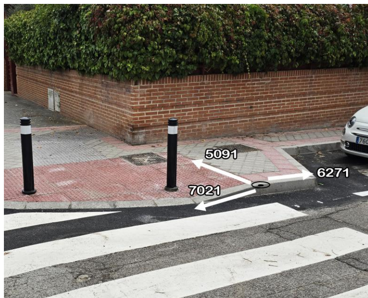
Figura 23. Código de punto formado por bordillo tipo III, bordillo tipo IX y loseta hidráulica roja abotonada (2025).
