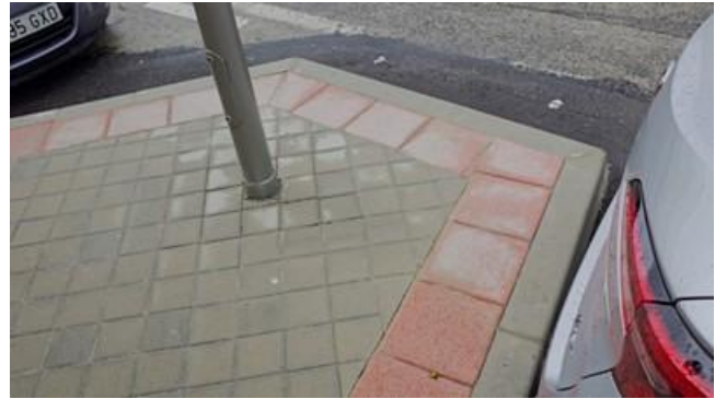
Figura 36. Estado ejecutado de ensanchamiento de acera en calle de Esparta (mayo 2025).
