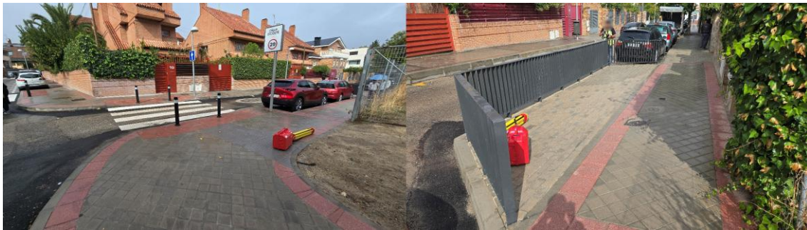
Figura 42. Estado ejecutado de orejetas peatonales y ensanchamiento de acera para instalación de barandilla tipo Río MU-72 en calle de Vicente Jiménez (mayo 2025).
