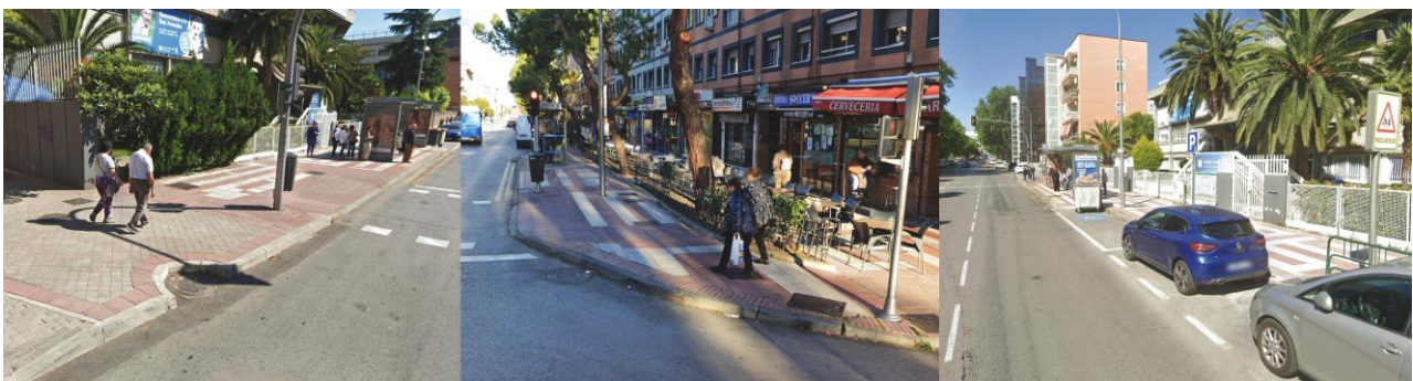
Figura 50. Estado existente de aceras y zona de estacionamiento reservado PMR en calle Alcalá. Fuente: Google Earth, junio 2024.
