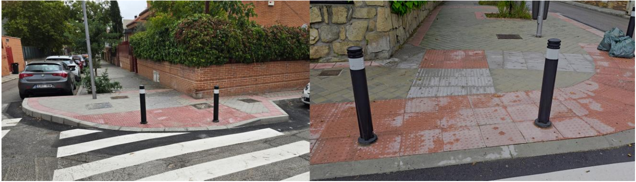
Figura 33. Estado ejecutado de orejetas peatonales en calle de Esparta (mayo 2025).
