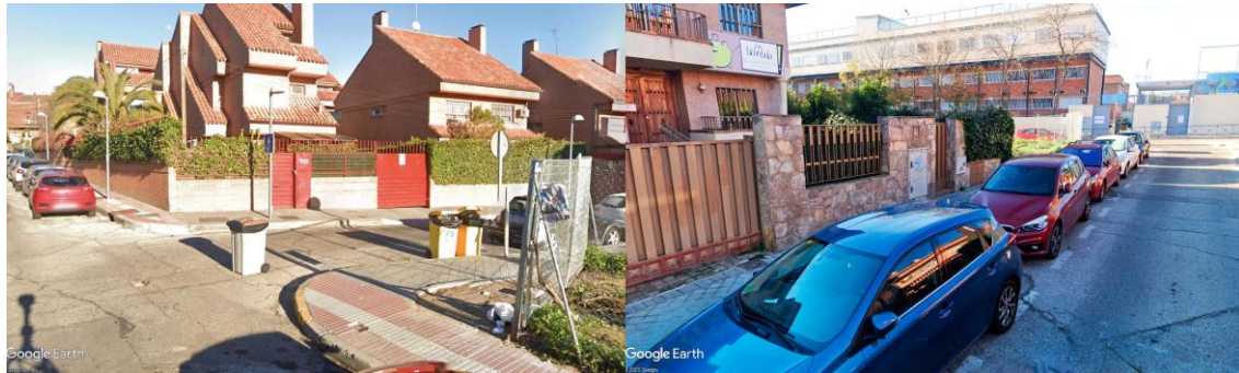
Figura 41. Estado existente de orejetas peatonales en calle de Vicente Jiménez. Fuente: Google Earth, enero 2022.
