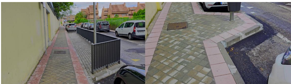
Figura 45. Estado ejecutado de ensanchamiento de acera para instalación de barandilla tipo Río MU-72 y desplazamiento de farola en calle de Esparta (mayo 2025).
