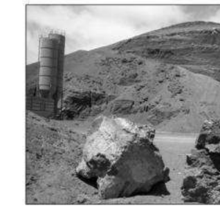
3.Mina de picón en Fuencaliente
