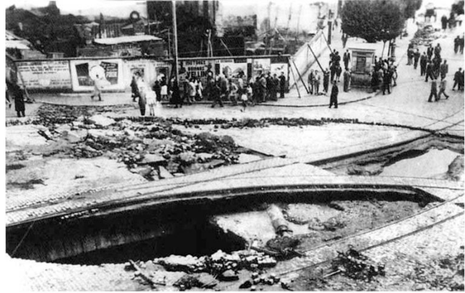
1.3 El reventón del embovedado del río Darro embovedado en Puerta Real
