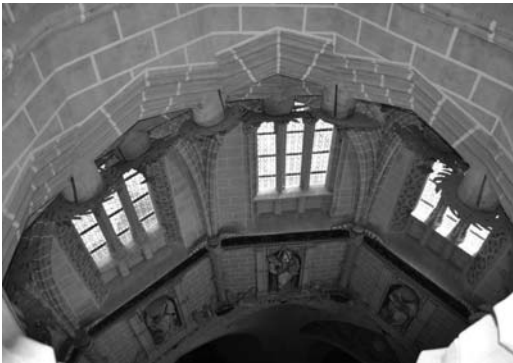
Figura 7 Vista de las intersecciones de los nervios de la parte superior del cimborrio (Foto: P. Fuentes)
