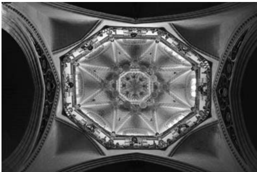
Figura 2 Vista interior del cimborrio (Foto: P. Fuentes)
