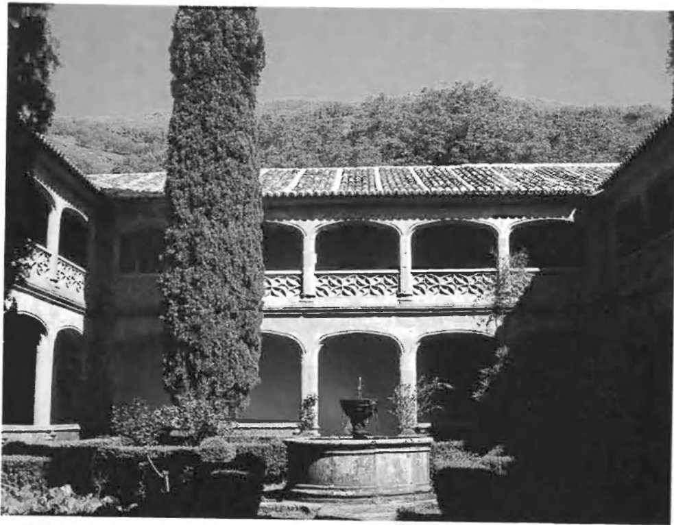
La restauración del claustro le ha devuelto todo su esplendor original.
