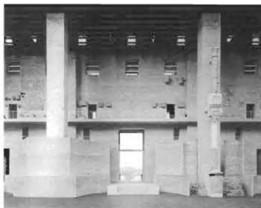
Detalle del nuevo escenario del Teatro tras la restauración.
