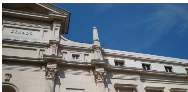
4.0: Vista general de la fachada con los 4 tipos de cornisa
