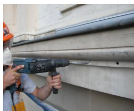
6.2: Ejecución de taladros
