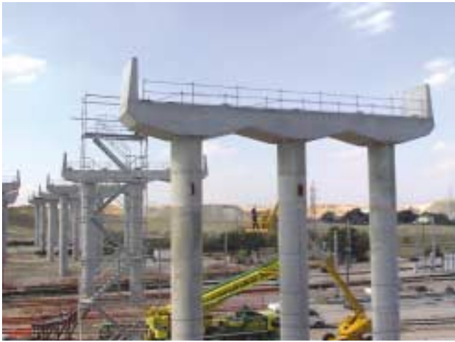
Fig. 1. Protección perimetral de capiteles.
