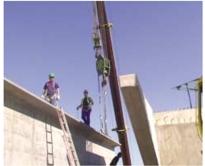
Fig. 4. Labores de colocación de vigas prefabricadas.
