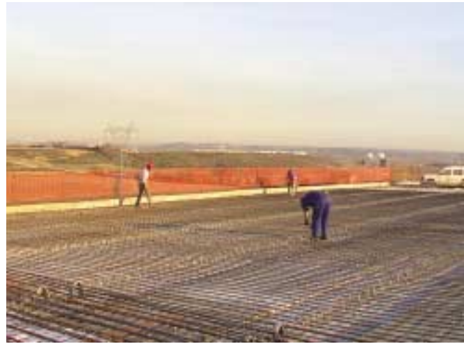
Fig. 2. Protección y balizamiento perimetral en la ejecución de un tablero.
