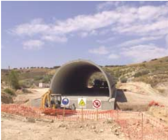
Fig. 3. Señalización y balizamiento de una bóveda prefabricada.
