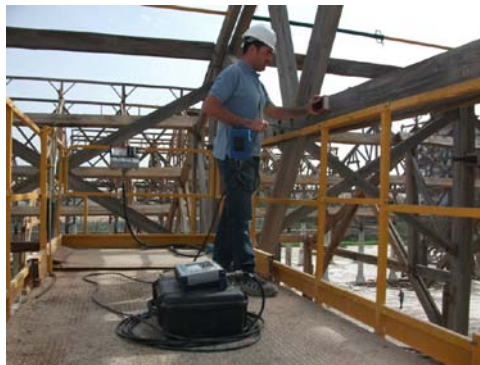
Fig. 5.- Equipo de georradar en el momento de medición de una viga
