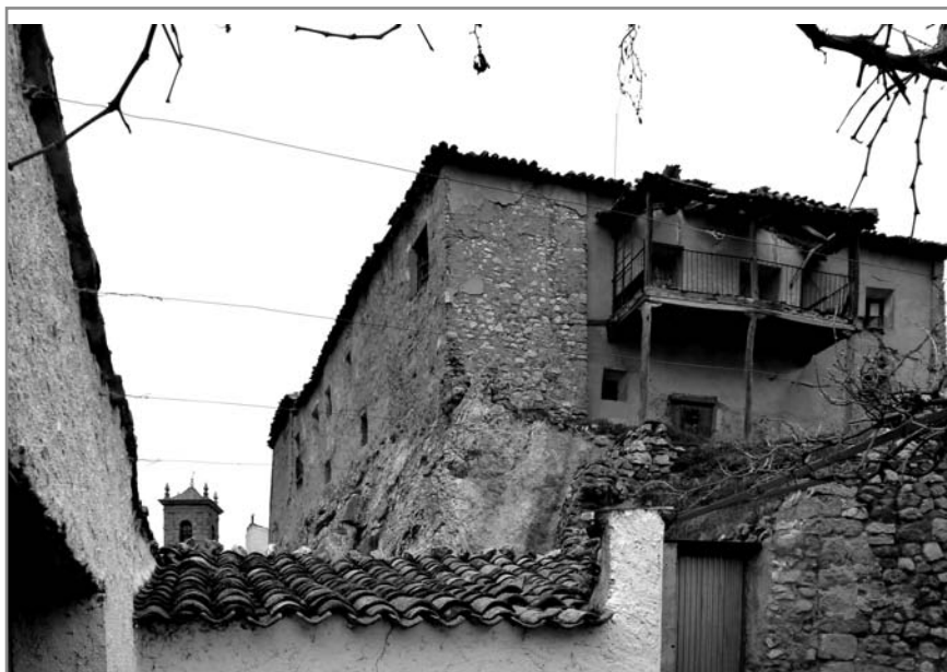
5. Casa Alta en Deza (Soria). Balcón mirador apoyado sobre pies derechos y zapatas.
