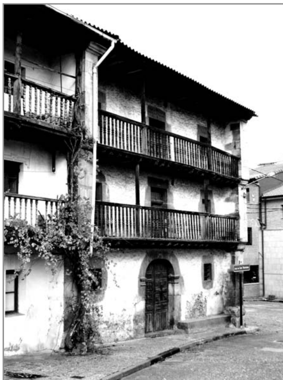
4. Balcones superpuestos en San Leonardo de Yagüe (Soria), siglo XVIII.
