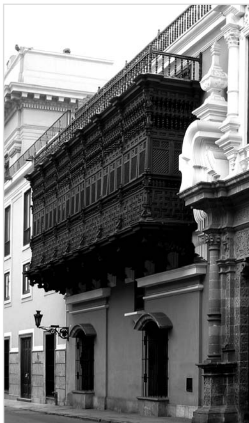
12. Balcón de celosía en Lima, Palacio de Torre Tagle.
