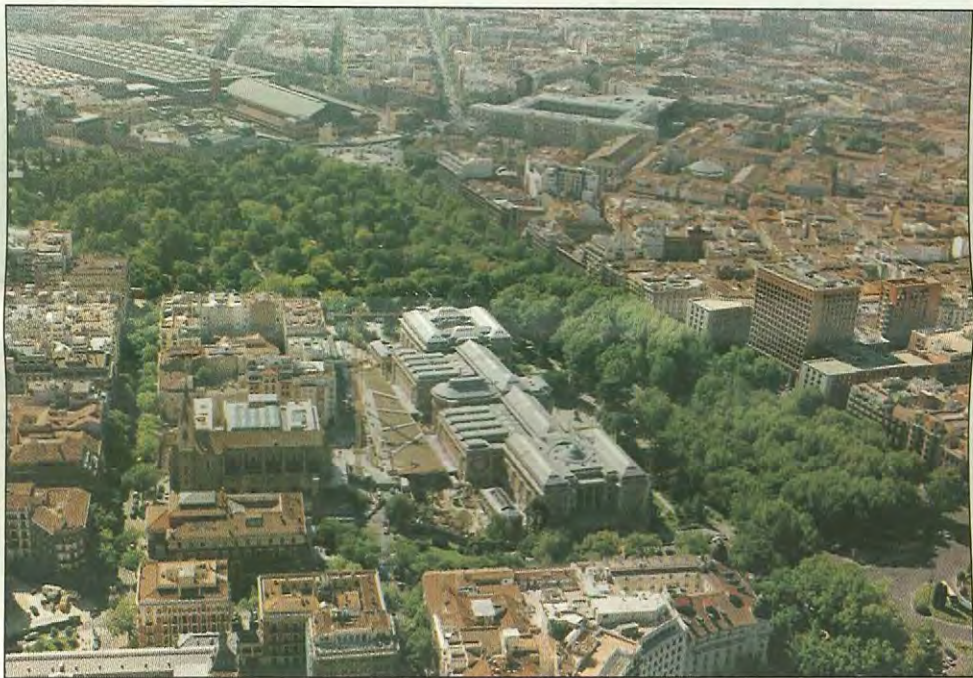
Veduta aerea del complesso del Prado; al centro, l'ampliamento e, a destra, il corpo principale progettato nel 1785 da Juan de Villanueva; in alto, la stazione di Atocha
