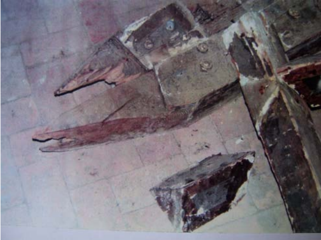
Fig.1. Detalle de encuentro de las limas dobladas en su cabecero con corte aflautado y una de las pequeñas manguetas de unión con el almizate.
