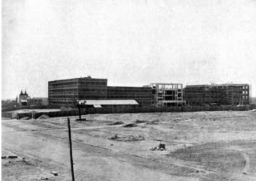
Estado de las obras el 17 de septiembre de 1933. Una cubierta provisional protege la entrada de los estudiantes al ala izquierda. Huarte y Cía. Dossier del edificio [1944]. Colección de Javier Ortega.
